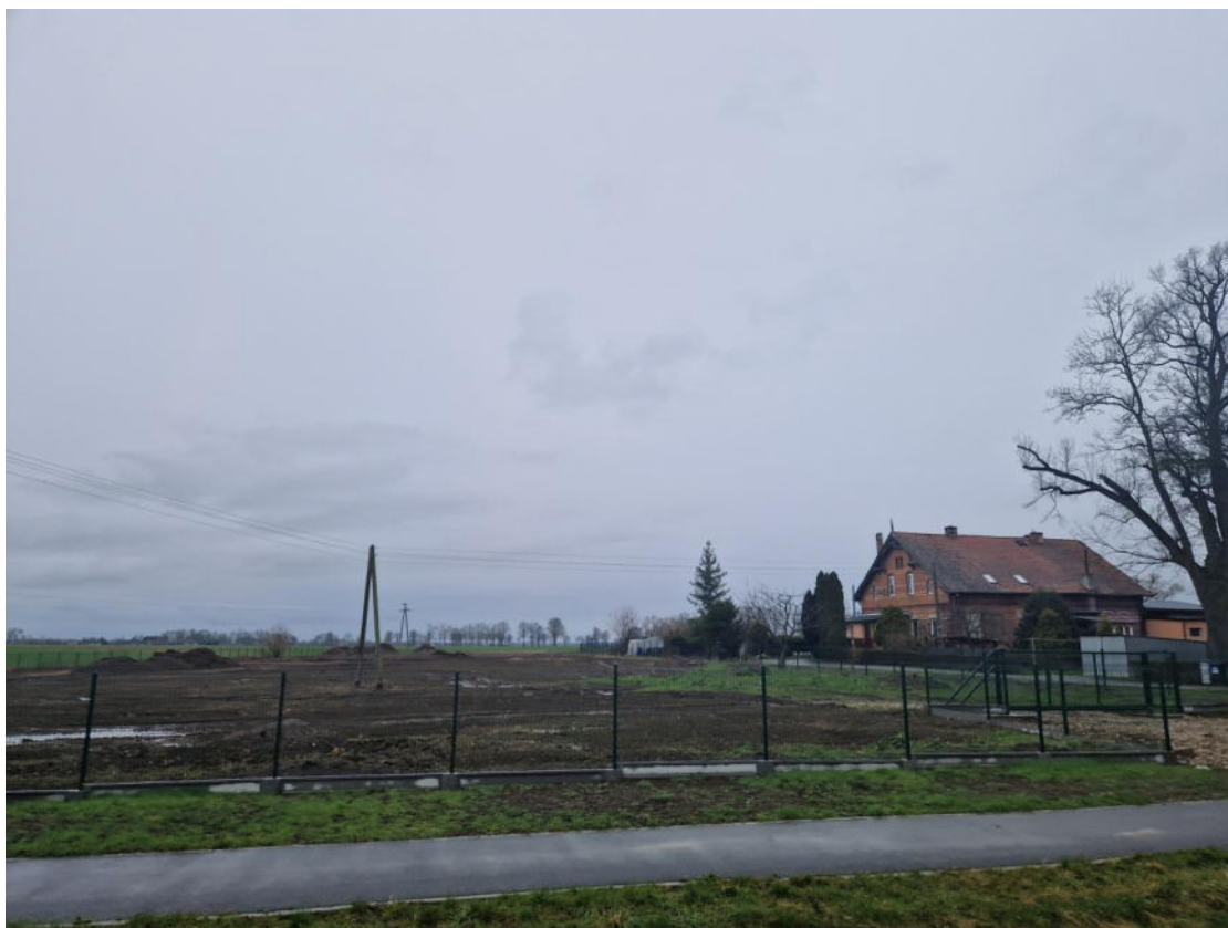
Fot. 2. Obszar opracowania widok z drogi gminnej w kierunku północno-zachodnim - po prawej Budynek zabytkowy (Krzyżanowo nr 4) położony poza obszarem opracowania.
