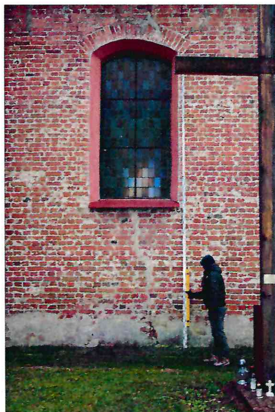
Fot. 22. Widok na ścianę północną korpusu kościoła
