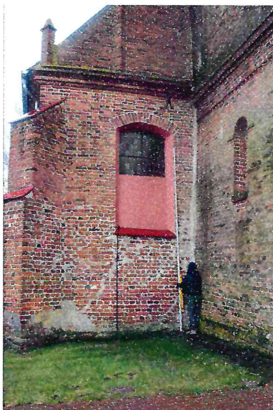
Fot. 4. Widok na ścianę zachodnią korpusu kościoła oraz miejsce łączenia wieży z korpusem.
