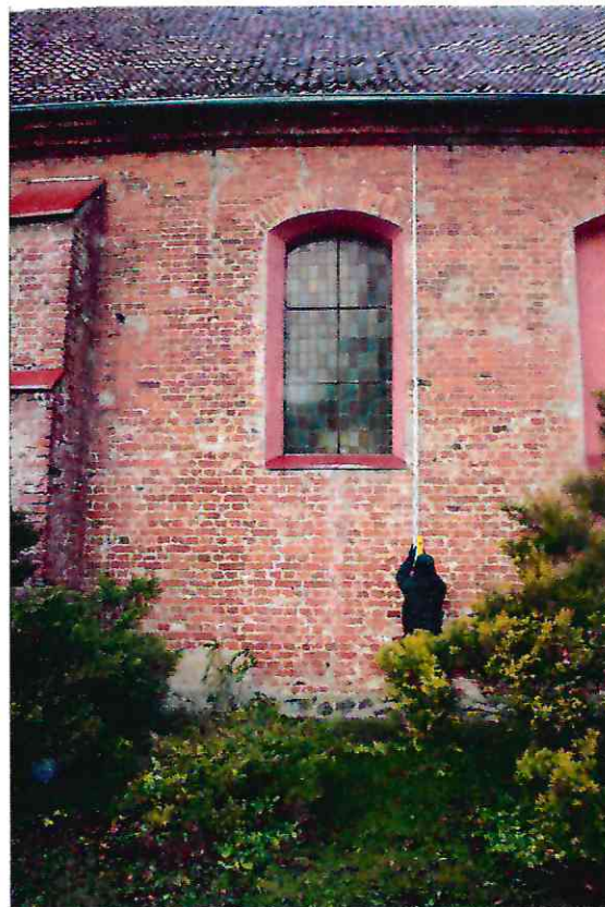
Fot. 14. Widok na ścianę południową korpusu kościoła
