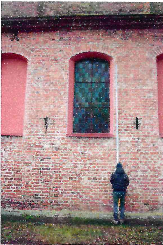
Fot. 18. Widok na ścianę wschodnią (szczytową) korpusu kościoła
