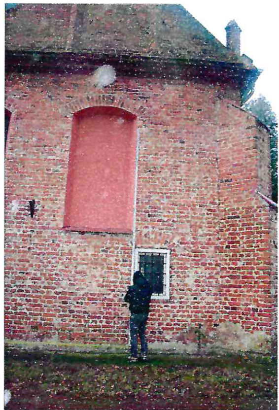
Fot. 19. Widok na ścianę wschodnią (szczytową) korpusu kościoła
