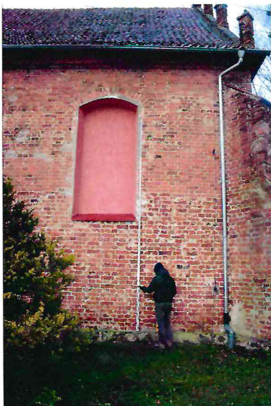
Fot. 15. Widok na ścianę południową korpusu kościoła
