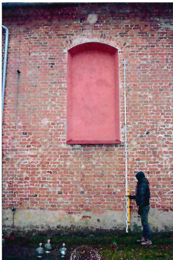
Fot. 20. Widok na ścianę północną korpusu kościoła
