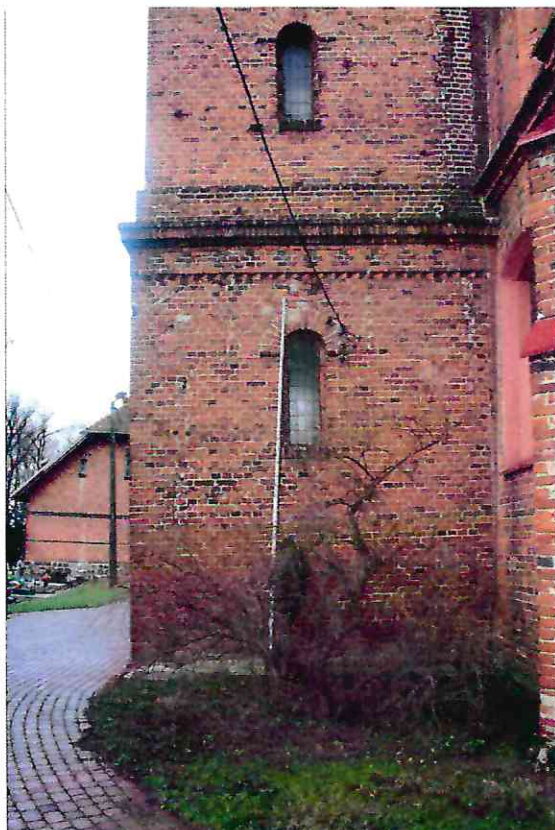
Fot. 7. Widok od strony południowej na dolny fragment wieży
