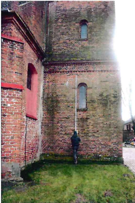
Fot. 5. Widok od strony północnej na dolny fragment wieży.
