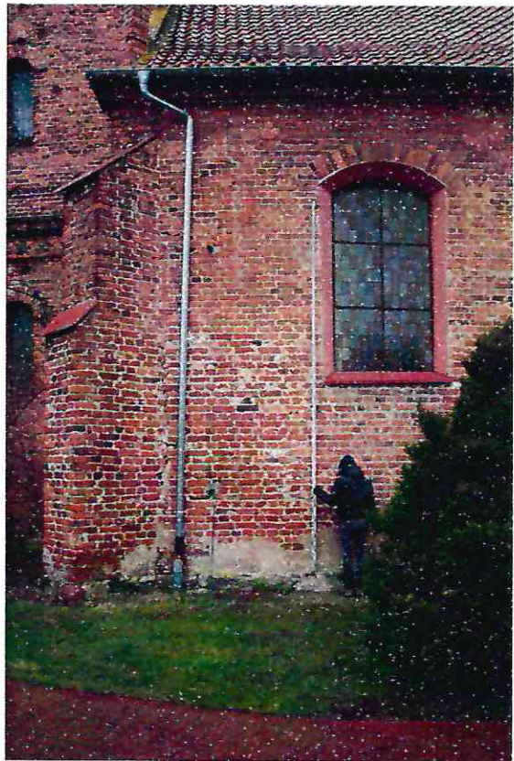
Fot. 12. Widok na ścianę południową korpusu kościoła
