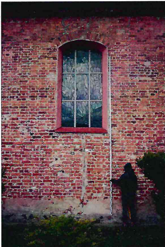
Fot. 13. Widok na ścianę południową korpusu kościoła
