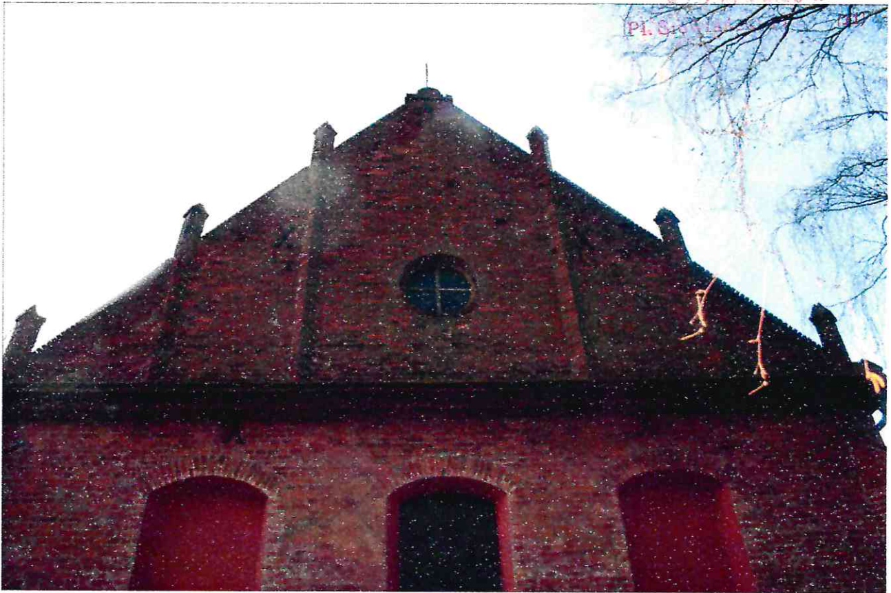
Fot. 16. Widok na ścianę wschodnią (szczytową) korpusu kościoła
