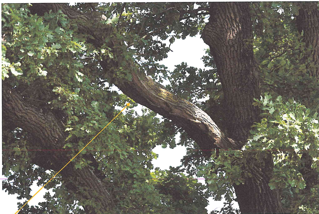
Zdj. 11 – konar ze śladami ubytku wgłębnego (bardzo silnie wykształcone wały zasklepowe) – konieczne wykonanie cięć odciążających i podwiązanie konara (asekuracyjne) przy użyciu wiązania elastycznego typu Cobra.
