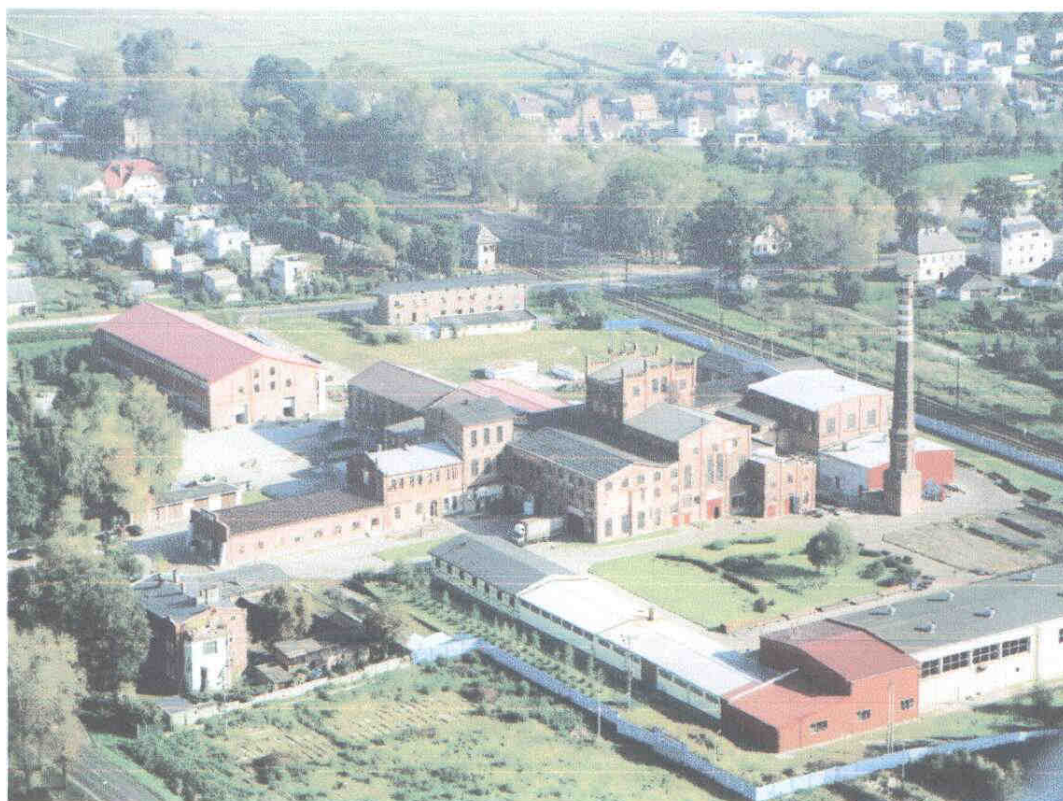
Kompleks budynków produkcyjnych i pomocniczych byłej cukrowni.
