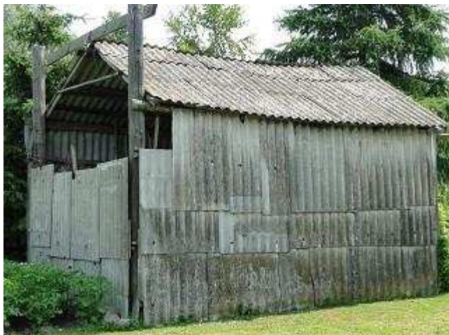
Zdjęcie 5. Wiata wykonana z płyt azbestowo-cementowych znajdująca się na terenie Ząbrowa
