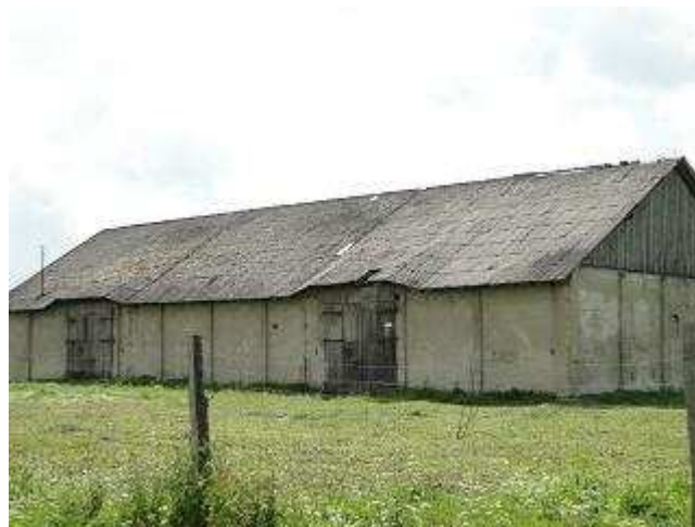
Zdjęcie 4. Wielkokubaturowy obiekt gospodarczy (stodoła) na terenie Krzyżanowa
