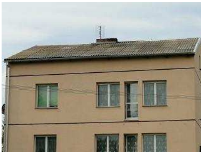
Zdjęcie 3. Dach wykonany z płyt azbestowo-cementowych na budynku mieszkalnym
