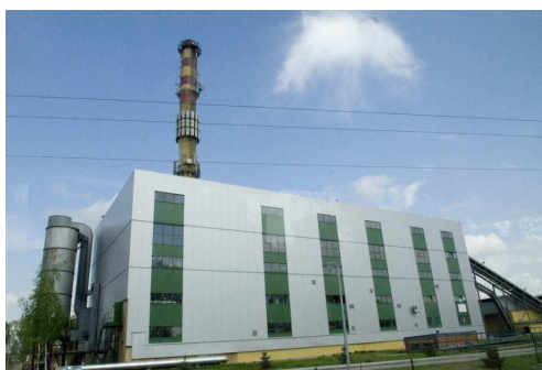
Ciepłownia na biomasę w Szwecji
