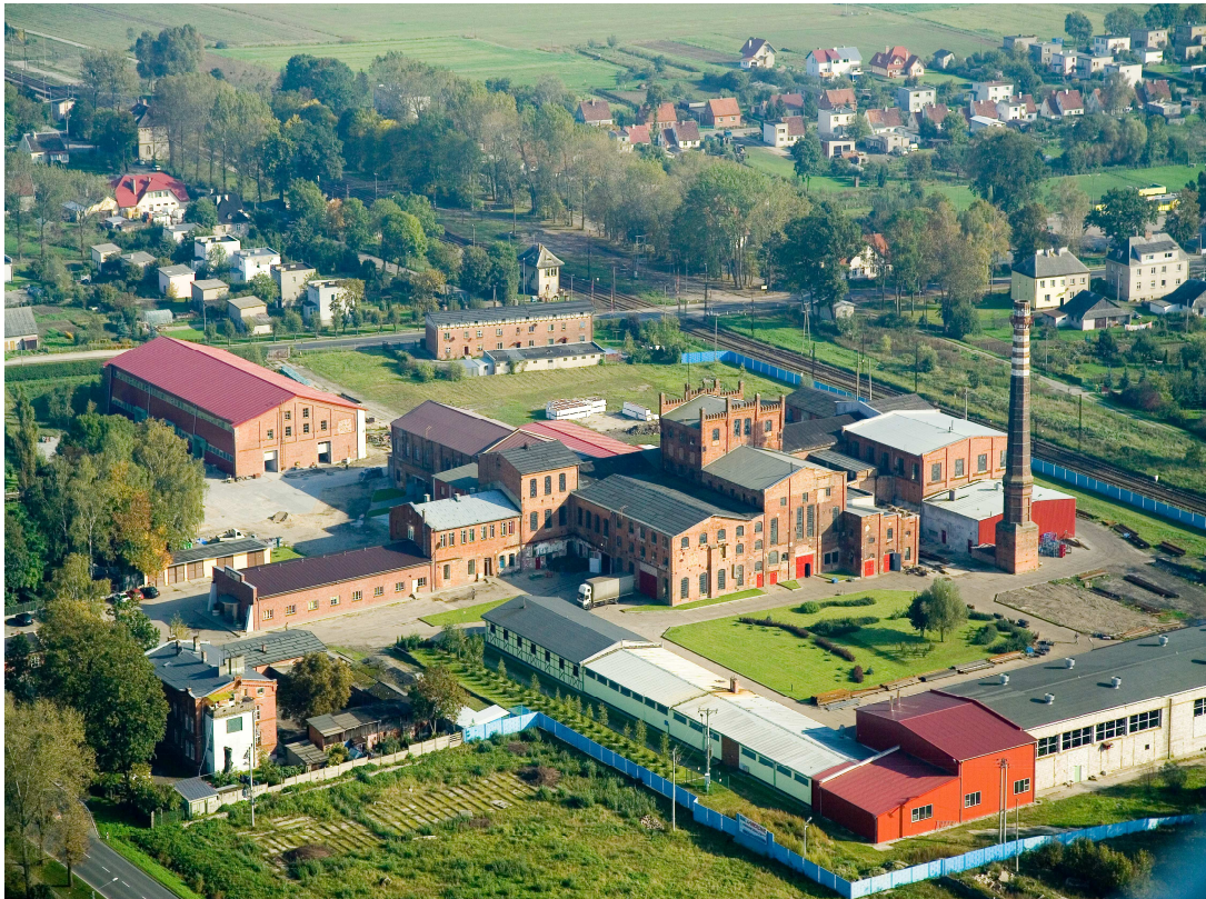
Kompleks budynków produkcyjnych i pomocniczych byłej cukrowni – obecnie siedziba firmy Dam-Rob.
