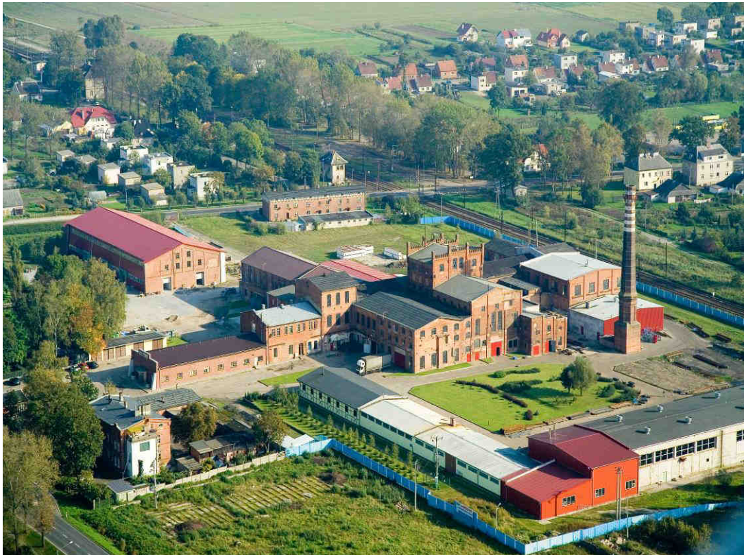
Kompleks budynków produkcyjnych i pomocniczych byłej cukrowni.
